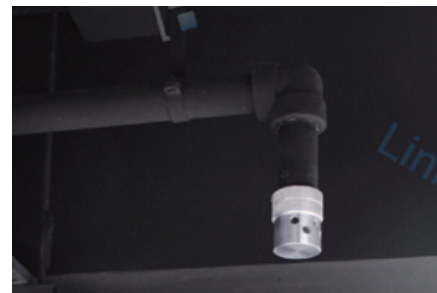
◆ 温度粉末传感器 发生火情传感器自动喷射 粉末扑灭火源。
